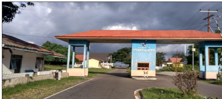
Gambar 3. Kondisi Gate (Pintu Gerbang pelabuhan Ippi Ende)
