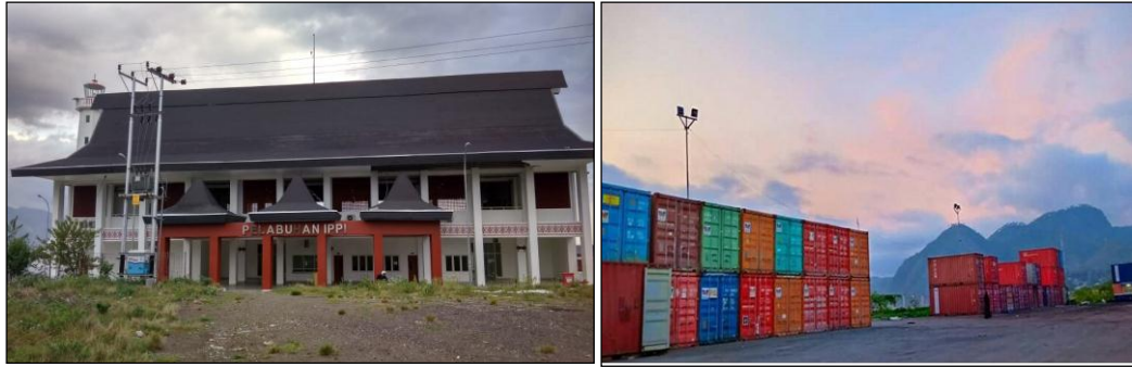
Gambar 2. Kondisi Fasilitas Terminal Penumpang Pelabuhan Ippi Ende.
