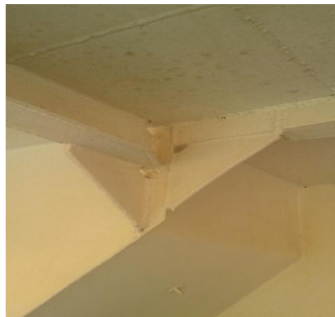
Gambar 1. Konstruksi Bracket (IMS Perintis,2018)
