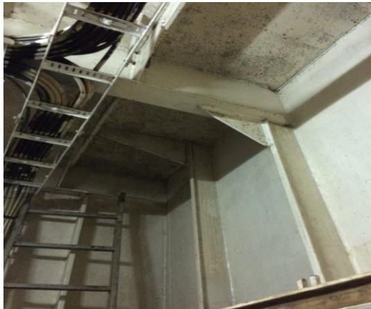
Gambar 2. Konstruksi Bracket (IMS,Perintis 2018)
